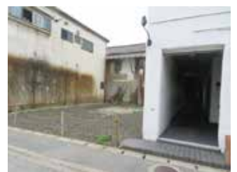
解体が終わった横町商店街の一角
