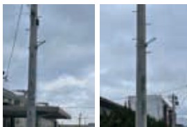
防犯灯の新規設置(令和6年度の設置は2基)
